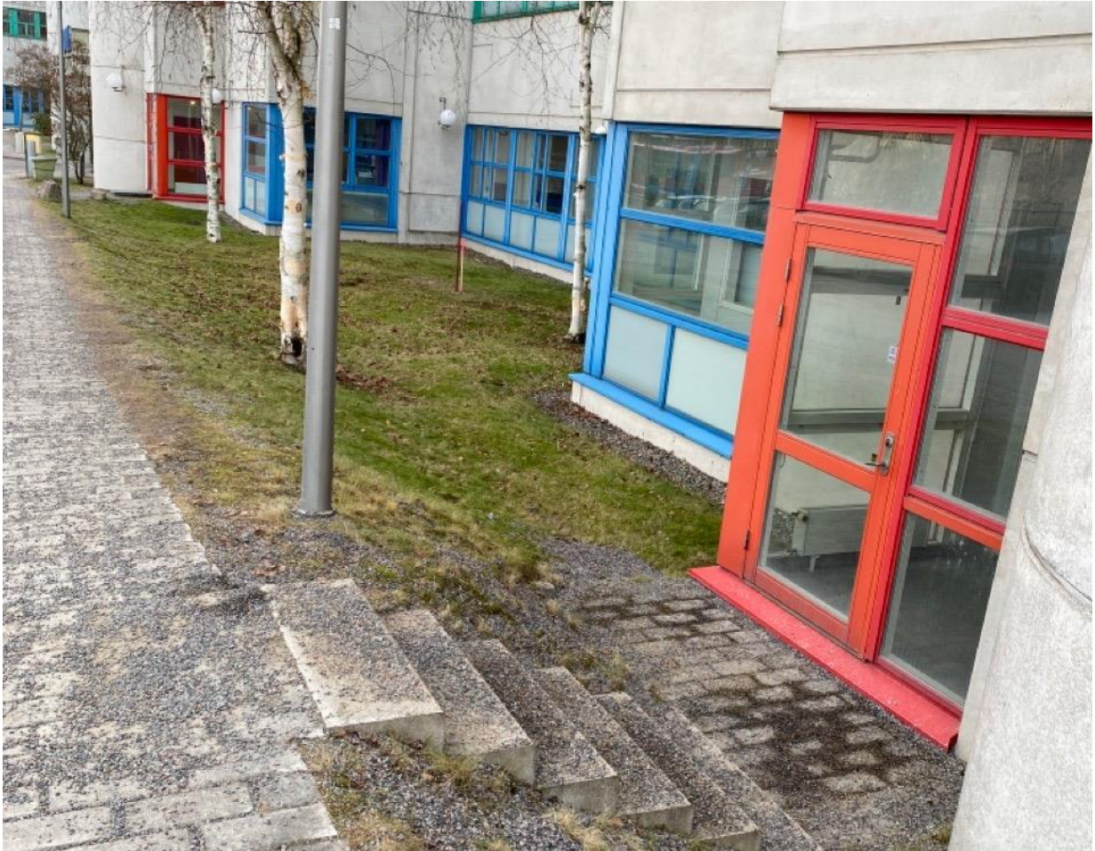
Figur 15. Del av lågpunkten B utmed den norra fasaden av den befintliga byggnaden. Bild tagen öster om huvudentrén.
