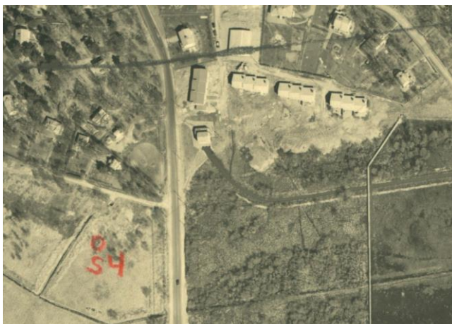
Bild 3: Flygfoto från 1958. Vatten från AP Invallningen avleds till en öppen kanal.
