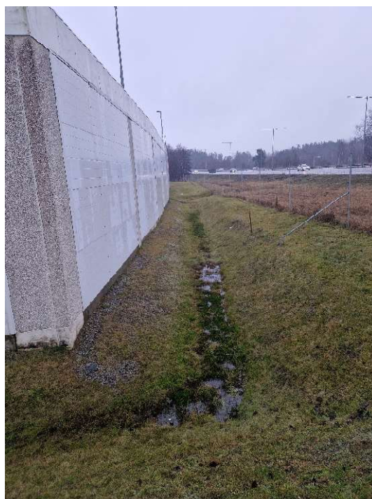
Figur 7. Dike längs med den västra fastighetsgränsen. Vy mot söder. Bild tagen vid platsbesök 2025-01-21.
