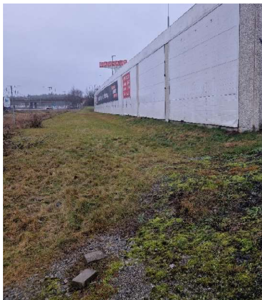
Figur 9. Vy över diken från söder mot norr. Anslutning från krossdike verkar täckt av vegetation. Bild tagen vid platsbesök 2025-01-21.
