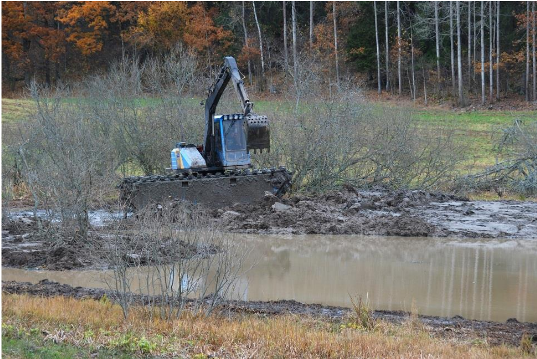
Grävning av våtmark vid Långängen i Orlångens naturreservat. Foto Richard Vestin.
