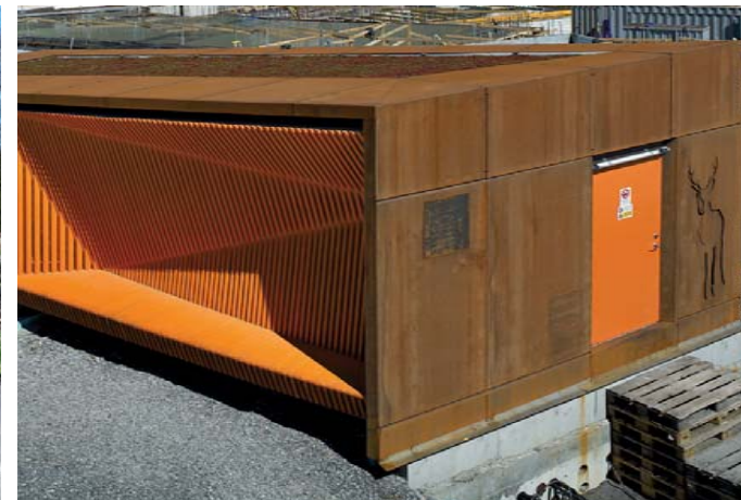
Teknikhus i corteenstål med ingraverat mönster och Sittplatser, Fortums teknikhus Norra Djugårdsstaden
