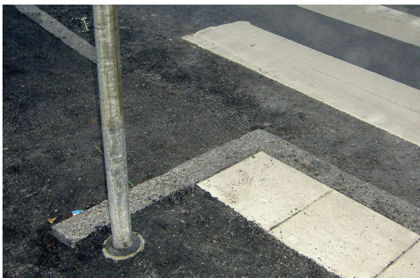
Övergångsställe med ramp och kontrastmarkering.
