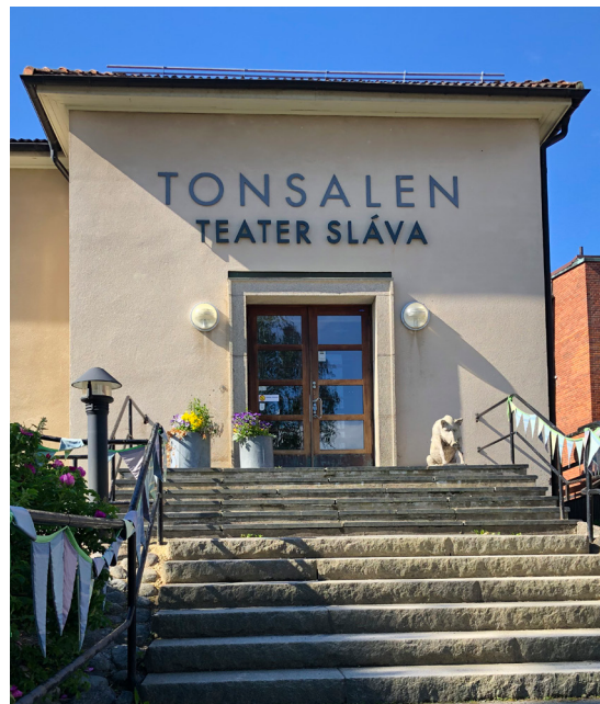
Exempel på friliggande bokstäver placerade på fasad. Bokstäverna harmonierar med byggnadens färgskala, symmetri och volym. Bokstäverna är infästa var och en för sig vilket ger ett stilrent uttryck.
