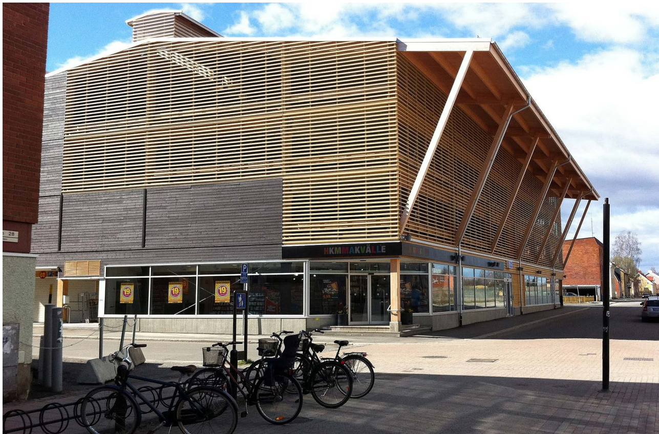
Parkeringshus i massiv- och limträ, Skellefteå av AIX Arkitekter (Bild: Enar Nordvik)
