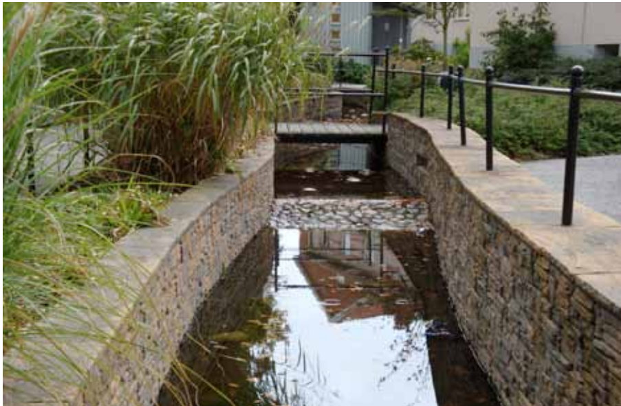
Uppsamlingskanal för gårdsvatten i Augustenborg. Foto: Dagvattengruppen Sweco.
