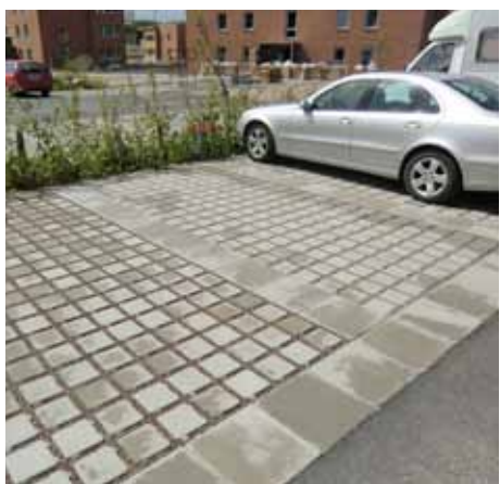
Parkeringsyta i form av betongplattor med genomsläppliga fogar där vattnet kan infiltrera. Augustenborg. Foto: Anette Björlin.
