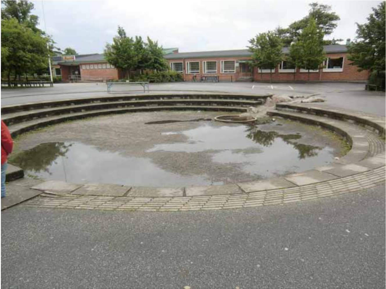
Amfiteater på skolgård som fungerar som samlingsplats, vattenlekplats och dagvattenfördröjningsplats. Amfiteatern fylls med regn vid rikligare nederbörd som sakta tränger ner genom grusbotten. Augustenborg.
