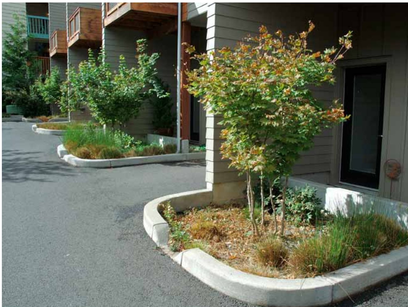
Nedsänkt växtbädd. Till växtbädden avvattnas takvatten som leds ner i växtbädden genom stuprör. Överskottsvatten bräddas via utsläpp i kantsten och ut på gatan. Portland, USA. Foto: Dagvattengruppen, Sweco.
