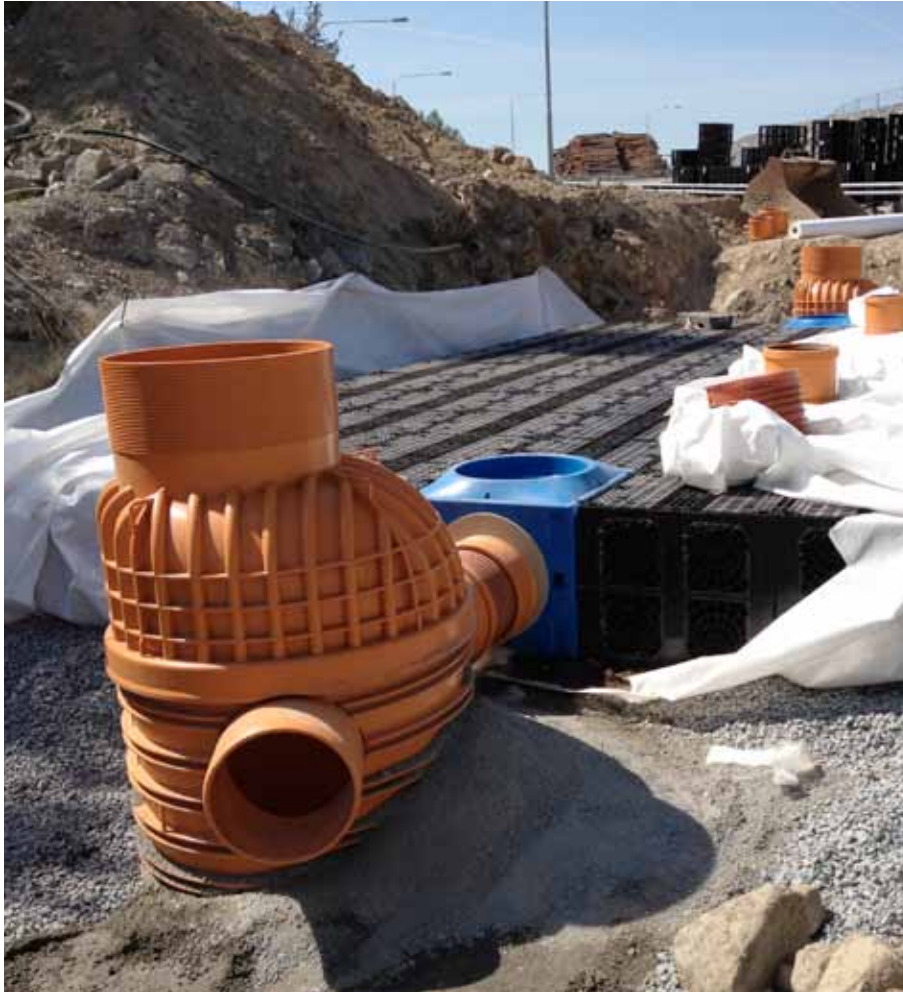
Anläggning av dagvattenkassetter för fördröjning och eventuellt infiltration av dagvatten. Brista, Märsta. Foto: Dagvattengruppen Sweco.
