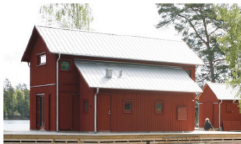
Falsat plåttak/ pannplåt
