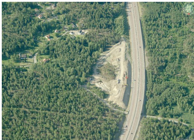
Vy från norr över bullervall under byggnation
