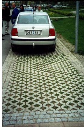
Parkering med rasteryta och betonghålsten
