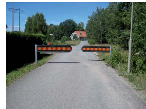
Mer påkörningsvänligt hinder
