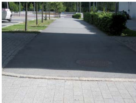
Kantsten tvärs nybyggd cykelbana vid Södertörns högskola, Alfred Nobels allé
