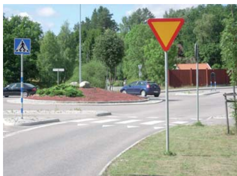
Cirkulationsplats med korrekt väjningsskyltning och målning. Ågestavägen/Peder Smedhs väg
