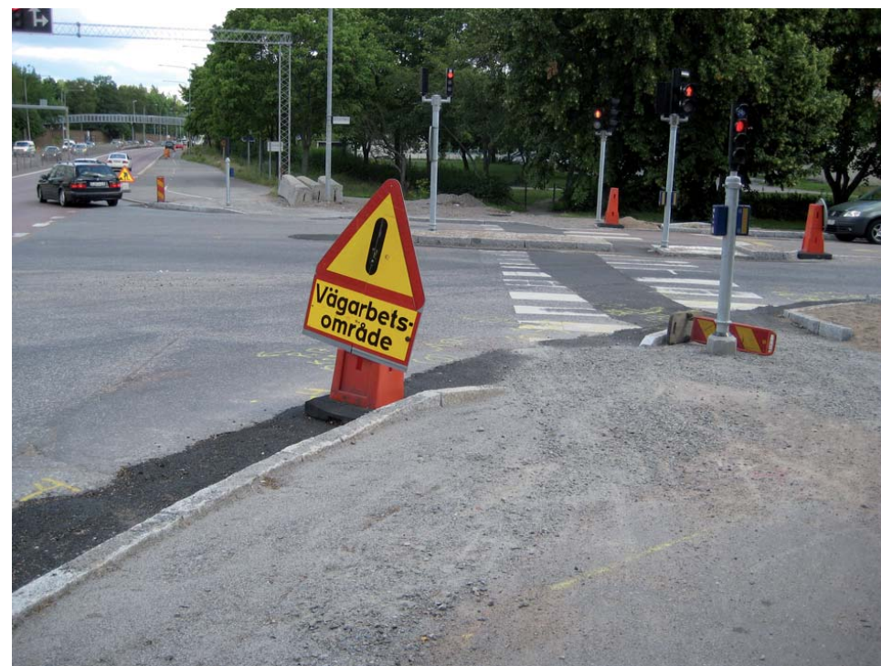
Gatuarbete vid korsningen Huddingevägen/Lännavägen
