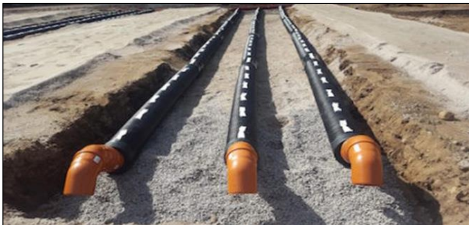
Figur 8. Övre bild: profil av en Savaq-lösning. Nedre bild: Foto vid anläggning av Savaq-rör.
