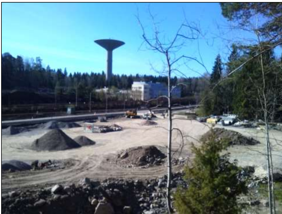
Figur 6. Vägbyggnation på utredningsområdet
