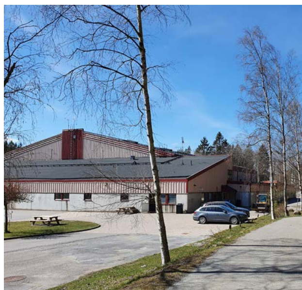
Visättrahallen, Kvarnängsvägen Foto: Lin Normark
