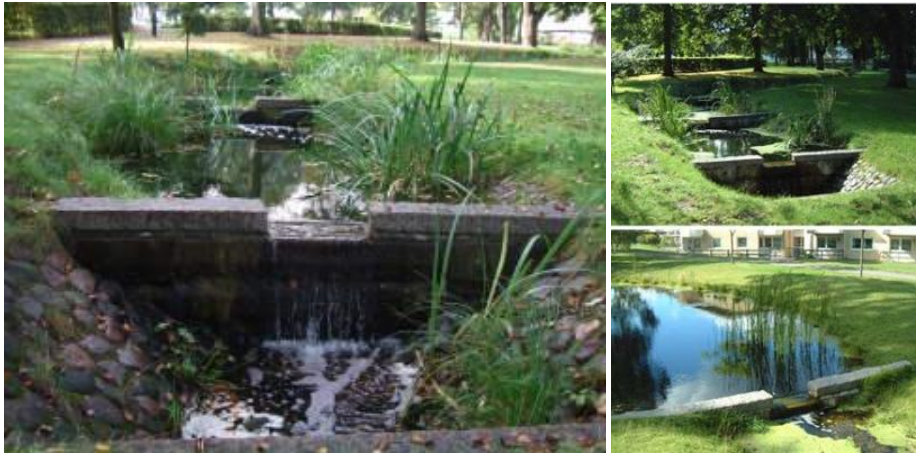
Figur 18. Trappad dikessektion med utjämningsdamm i Västerviks Stadspark (Svenskt vatten P105, 2011).
