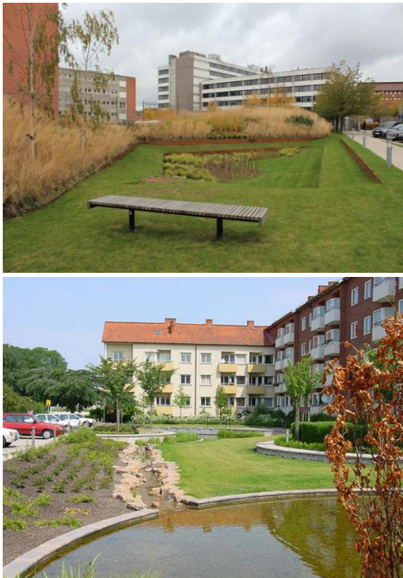
Figur 19. Ovan: Fördröjningsyta som är utformad som en trappad grönyta i Hisingen, Göteborg. Nedan: Dagvattenränna som leds ut till fördröjningsmagasin i Augustenborg i Malmö.
