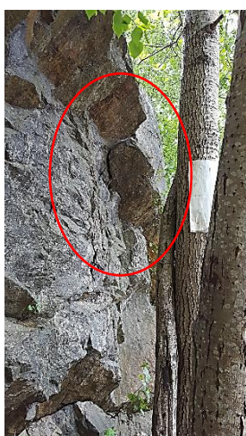
Figur 21 Exempel bomt berg område 3. Röda cirkeln visar lösa block med brant stående sprickplan. Finns fler bomma partier.
