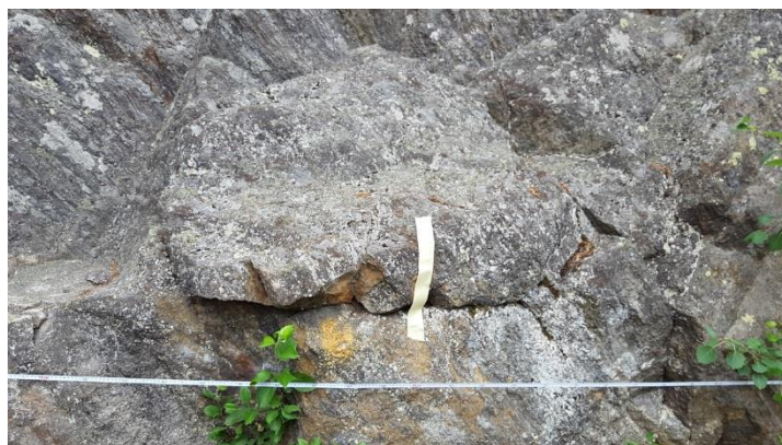
Figur 6 Lm A20 bomt block med kraftig apertur.
