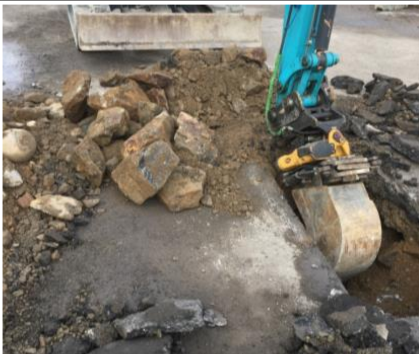
Figur 3. Schaktning av massor inför provtagning av underliggande material. Bilden visar markens sammansättning av sand, grus och block.
