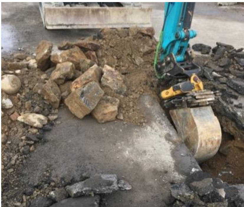
Figur 5. Schaktning av massor inför provtagning av underliggande material. Bilden visar markens sammansättning av sand, grus och block.
