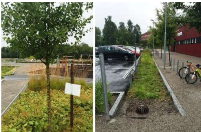
Exempel på en växtbädd runt ett träd till vänster och en växtbädd som renar dagvattnet från en parkering till höger.
