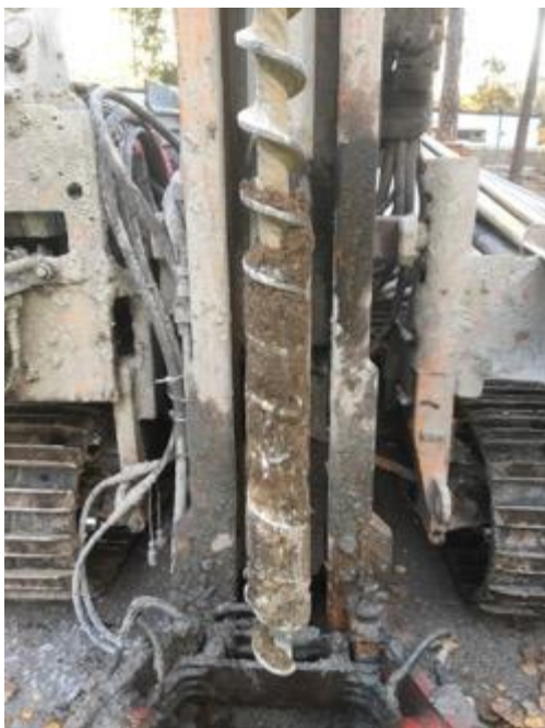
Figur 6. Figuren visar borrhigg samt miljöskruv efter att ha tagit upp jord från en borrhpunkt vid Utsäljeskolan.
