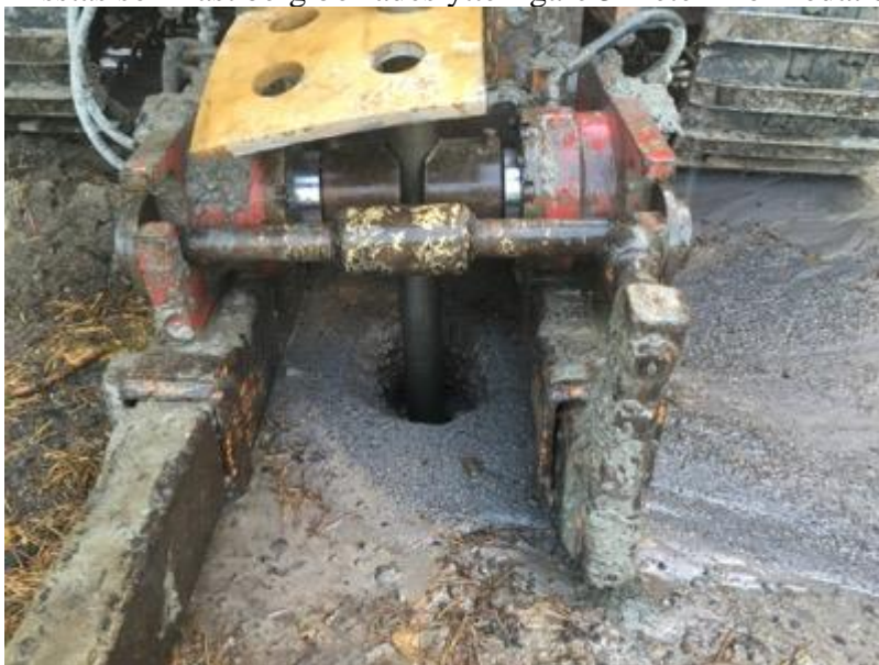
Figur 5. Figuren visar en utav borrhullarna under genomförandet av en jord-och bergsondering vid Utsäljeskolan.
