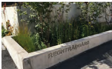
Regnbäddar för infiltration och fördröjning av dagvatten (referensbild)
