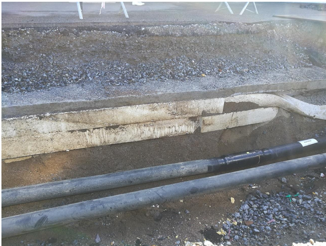
Figur 5. Foto från ledningsgrav som togs i samband med grundvattenprovtagning.
