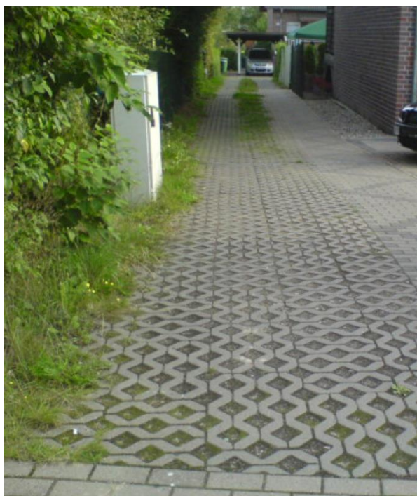
Figur 16. Exempel på genomsläpplig betongbeläggning. Källa: Stockholms stad, 2018.
