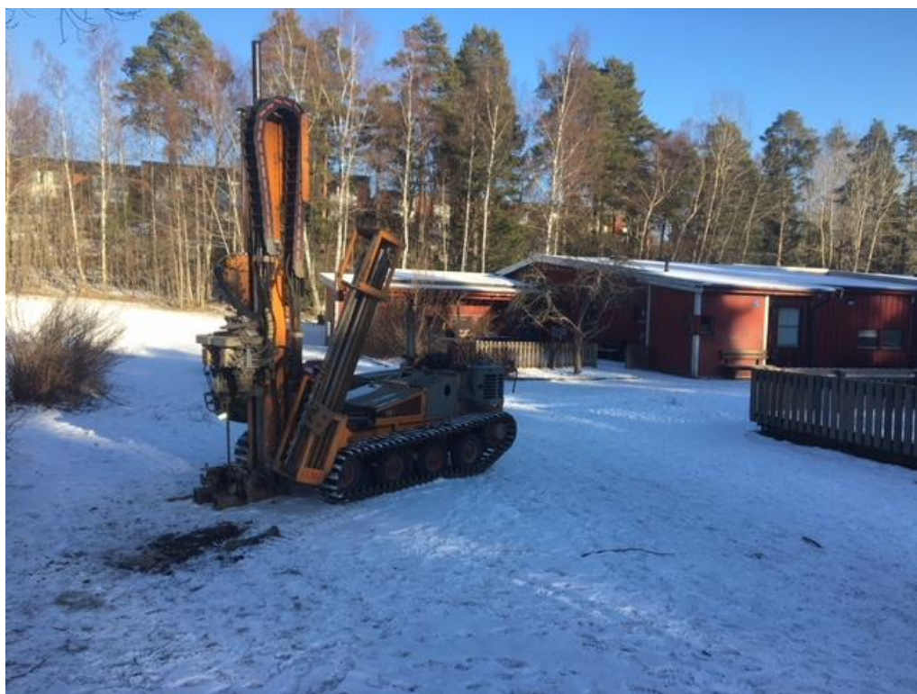
Bild 1 – Del av undersökningsområdet med COWI borrhandsvagn. Norr är till vänster i bild.
