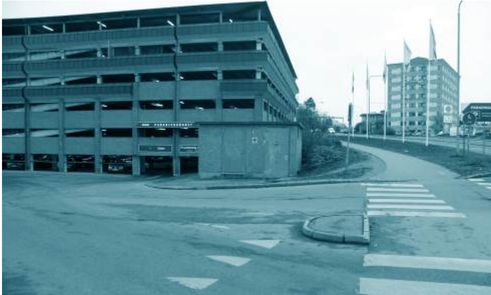
Figur 13: Exempel på ett i huvudsak "tekniskt rum" (Paradisgaraget vid Kommunalvägen)
