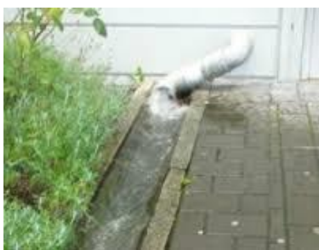
Stuprörsutlopp med kraftigt flöde till markränna och grönyta.
