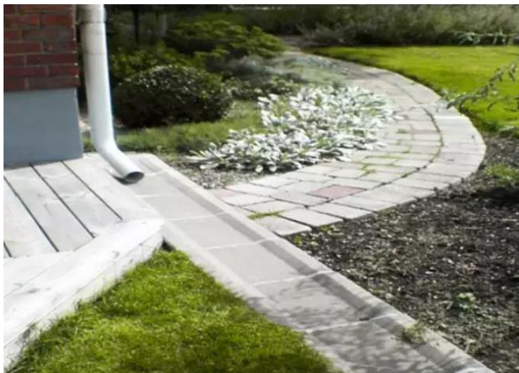
Exempel på avledning av stuprör till grönyta.
