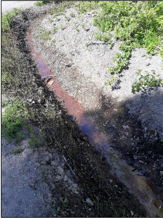
Figur 10. På bilden ses ett öppet dike med oljerester längs med Lagervägen (Foto: Norconsult, 2017-06-02)
