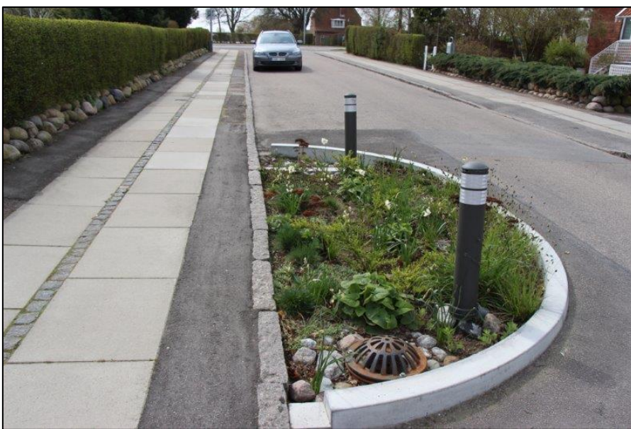
Figur 32. Exempel på utformning av regnbädd där dagvattnet avleds till grönytan via en öppning i kantstenen (Foto: Norconsult)
