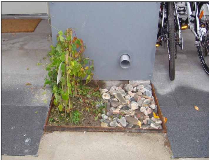
Figur 31. Exempel på utformning av regnbädd där takvattnet leds direkt till regnbädden (Foto: Norconsult)
