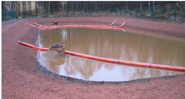
Sedimenterings- och buffertdamm som är tätad med gummiduk
