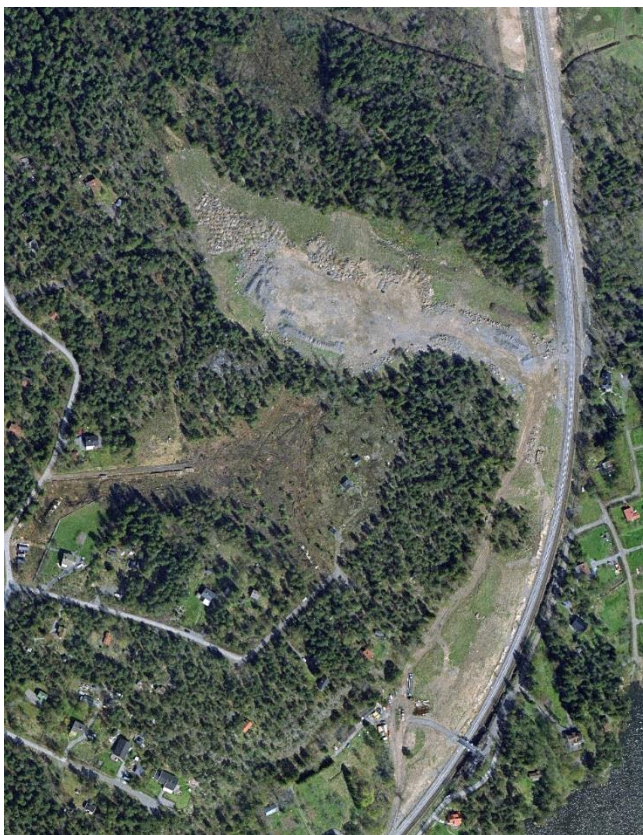
Figur 4. Flygbild från planområdet från år 1995 som visar det tidigare deponiområdet. Numera är deponin ej aktiv och området gräsbeklätt. Återställningsarbetet enligt den gamla deponiförordningen är inte genomförd.
