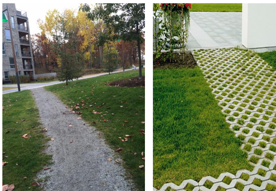
Figur 16. Bilder på genomsläppliga beläggningar. Grus i vänstra bilden, och markarmering i betong i högra bilden.
