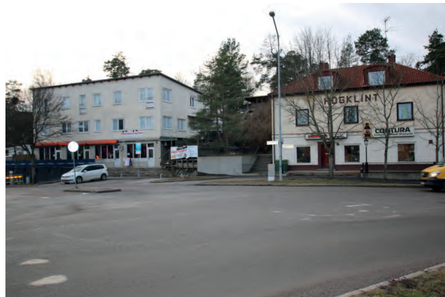
t.h: Centrumhuset och Högklint, båda upp- förda under 1930-tal.
