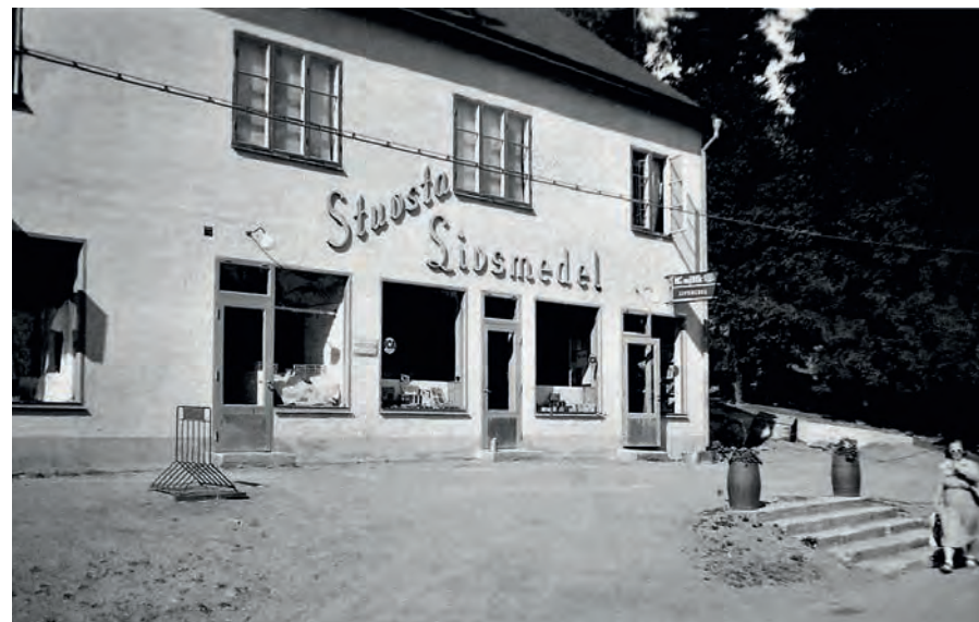
t.h: Stuvsta Livsmedel, Häradsvägen 1 (Odin 6) uppfördes om- kring 1929-30 med en bostadslägenhet för ägaren med butiker i bottenvåningen. Foton: Ur Hans Björkman, Stuvsta - väster om Huddingevägen.
