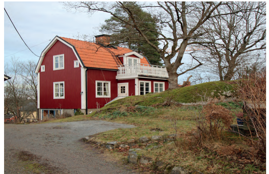
t.h: Villabyggnad intill fastigheten Odin 3.
