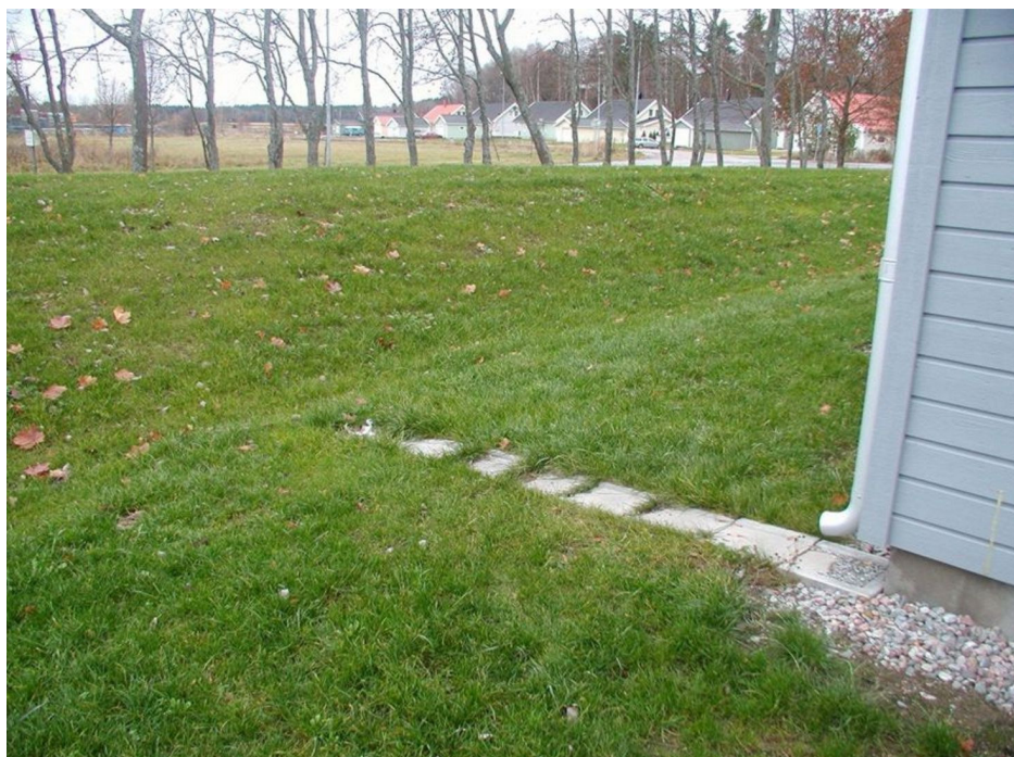
Figur 8. Utkastare och rännralsten med bra fall som avleder takvattnet till ett gräsbevuxet svackdike.
