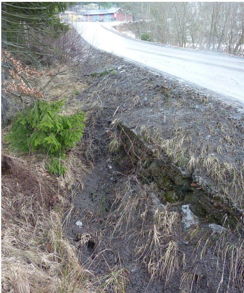
Figur 4. Trumma under Gamla Stockholmsvägen som leder vatten mot Källb-rinksdammen.
