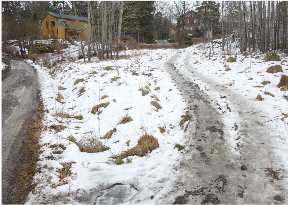
Figur 3. Gångvägen som leder ner mot Gamla Stockholmsvägen från "Säckgatan" fungerar också, oavsiktligt, som dike för avledning av dagvatten.
