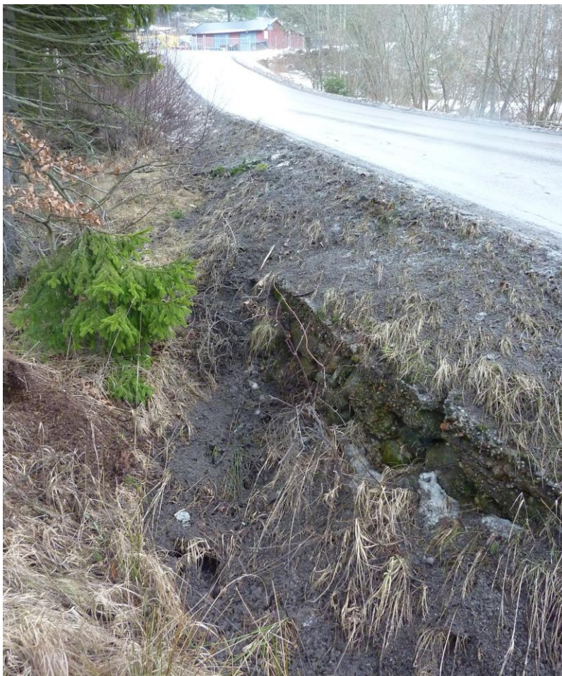
Figur 5. Trumma under Gamla Stockholmsvägen som leder vatten mot Källbrinksdammen.
