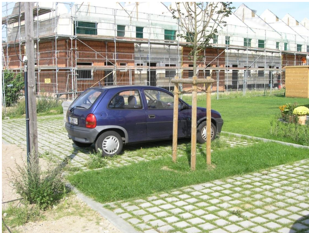
Figur 7. Parkeringsplats med permeabel beläggning i Lübeck, Tyskland. Foto Daniel Stråe, WRS.
