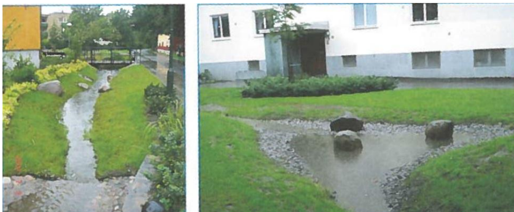
Bild 2. Öppna avvattningsstråk med vattenspegel (Figur 9.27 i P105).
