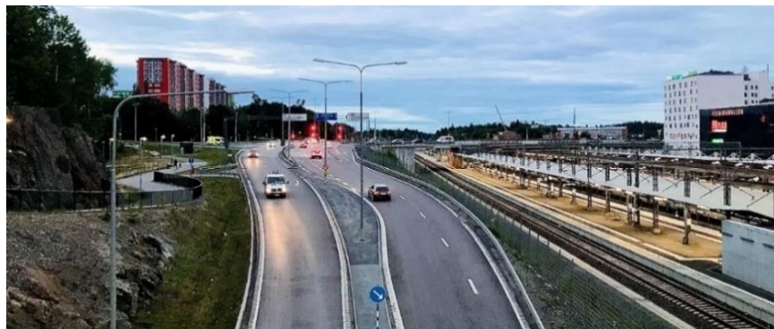
Huddingevägen och järnvägsspåret; Grantorp till vänster och Flemingsbergsdalen (och Visättra) till höger.
