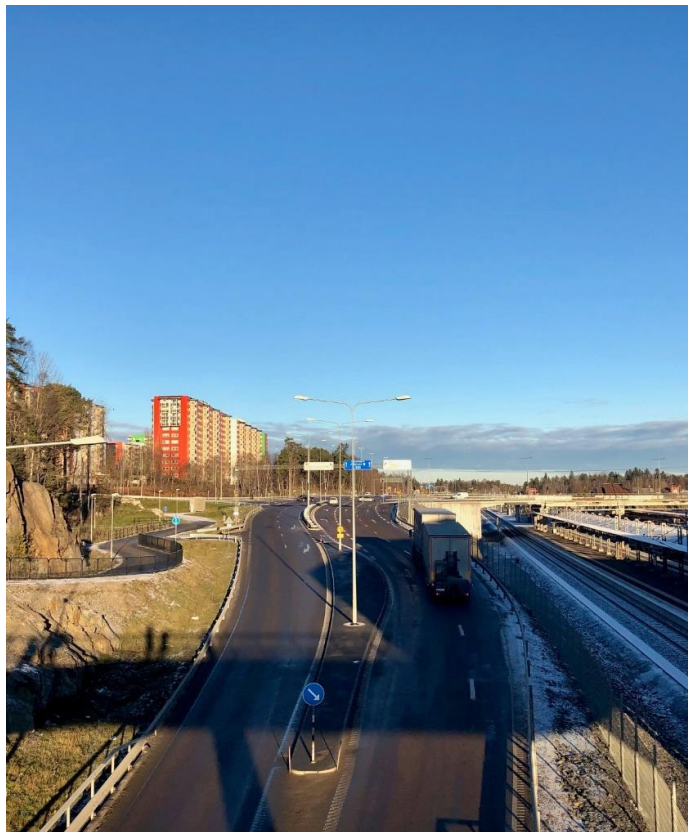
Figur 1. Vy mot norra entrén, visar väg 226, Regulatorbron och järnvägen. Foto: ÅF.
