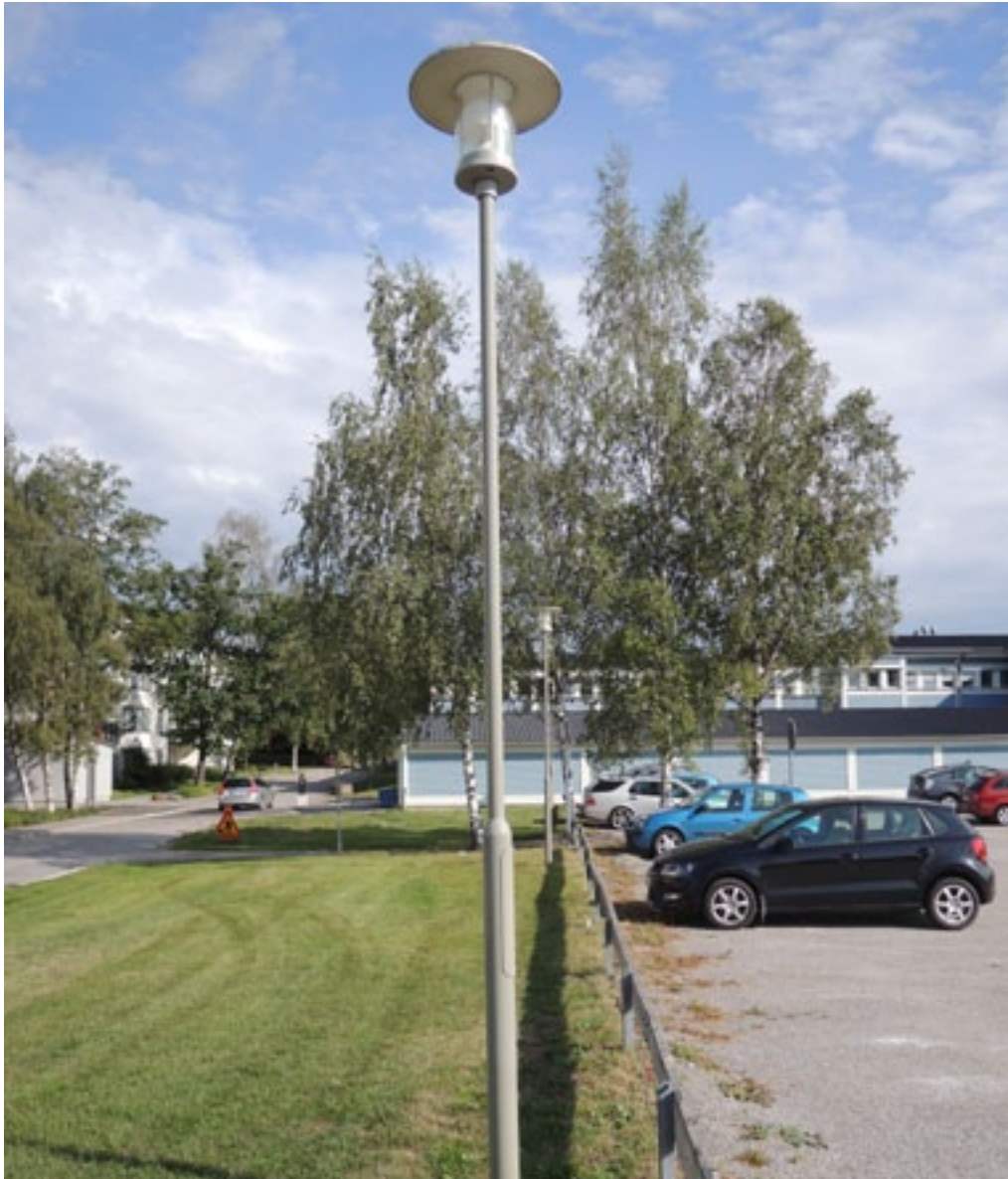
Målade belysningsstolpar avger en tredjedel så mycket zink som omålade. Tekniska nämndhuset. Foto: Annika Blomquist.
