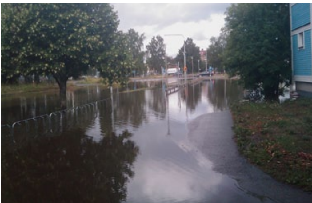
Översvämmning på Sjödalsvägen utanför Tekniska nämndhuset. Foto: Conny Bolander.
