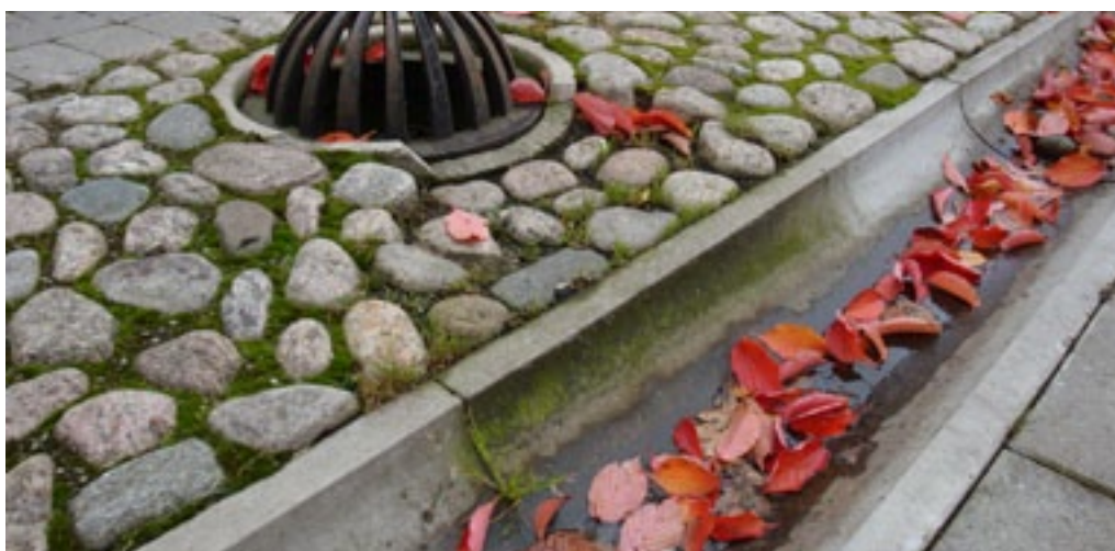
Dagvattenränna och kupolbrunn, Augustenborg. Foto: Dagvattengruppen Sweco.
