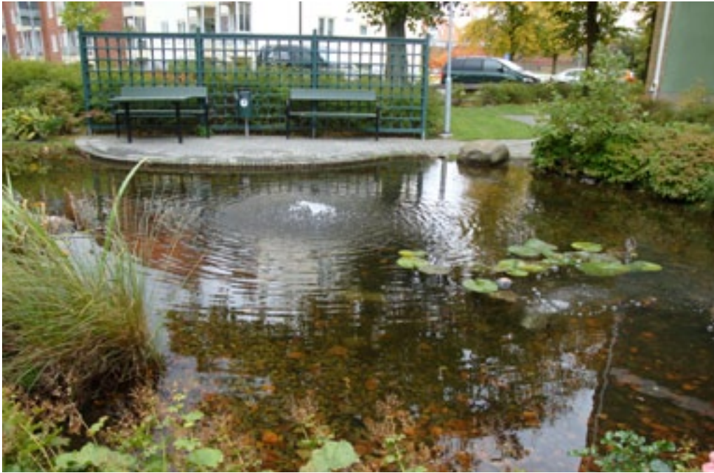
Damm i bostadsområde, Augustenborg. Foto: Dagvattengruppen Sweco.
