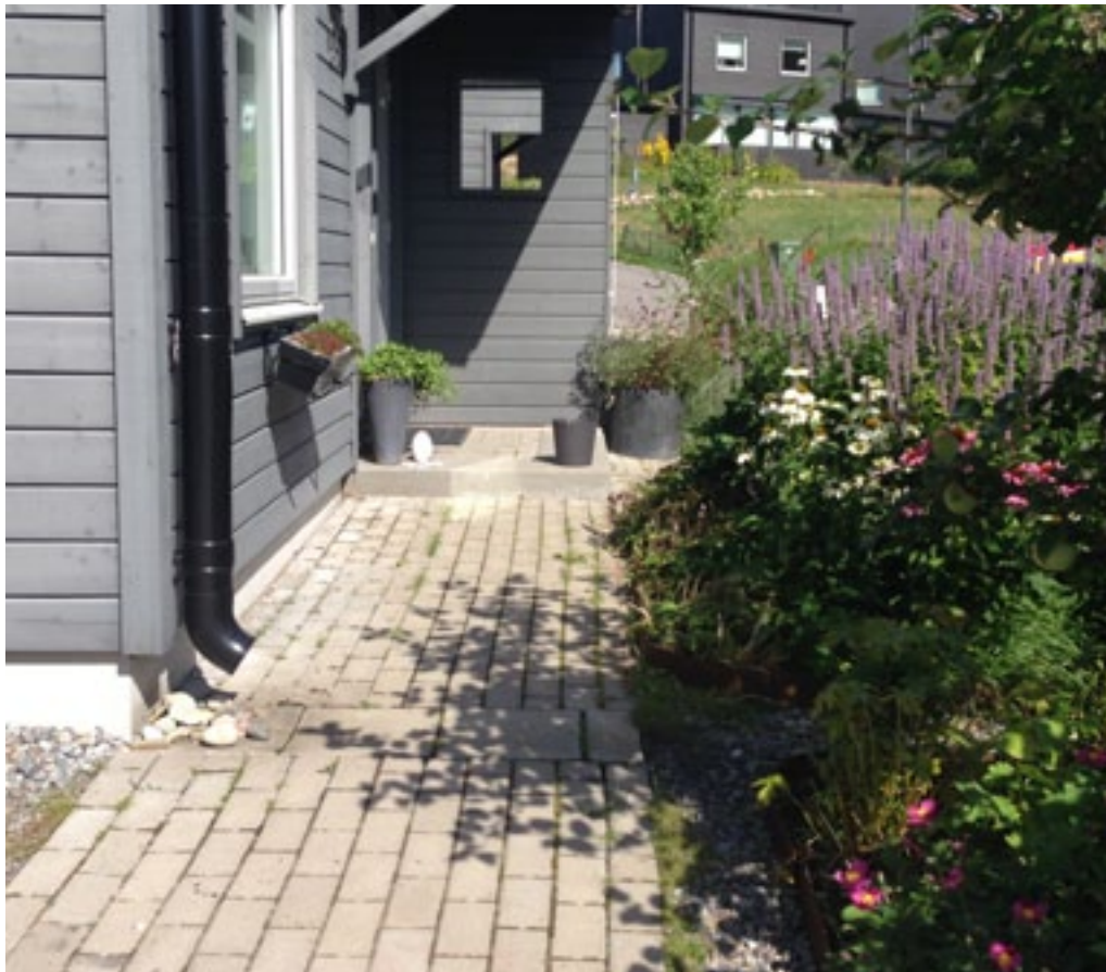
Dagvattenutkastare och rännalsplattor, Östra Balingsnäs. Foto Dagvattengruppen Sweco.
