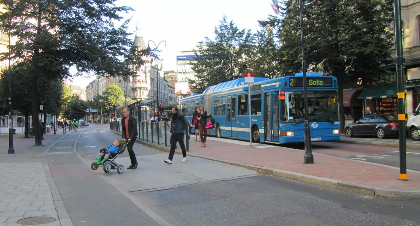
Bild 14: Med hjälp av räcken styrs passagerarna till den upphöjda gångpassagen till/från plattformen vid mittförlagt busskörfält. Birger Jarlsgatan, Stockholm. Foto: Karin Hassner, WSP.
