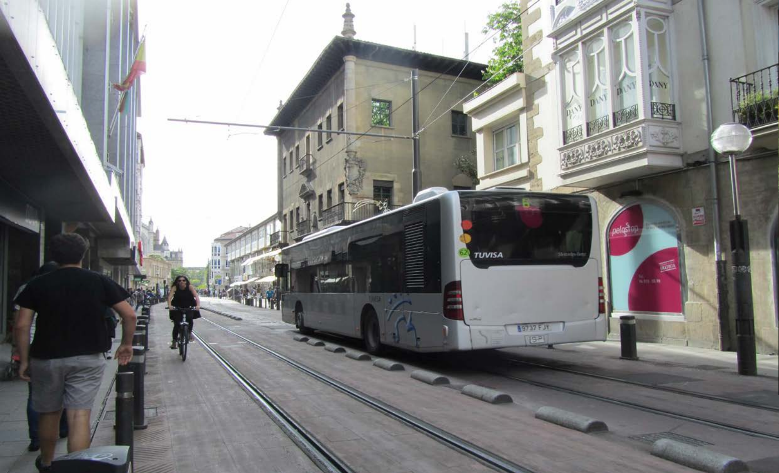
Bild 5: En smal gata har förvandlats till en ren kollektivtrafikgata för buss och spårvagn. Gångbanorna, som är i samma nivå som körbanan, är avgränsade med pollare. Cykling är inte tillåten, även om det förekommer ibland. Vitoria-Gasteiz, Spanien. Foto: Karin Hassner
