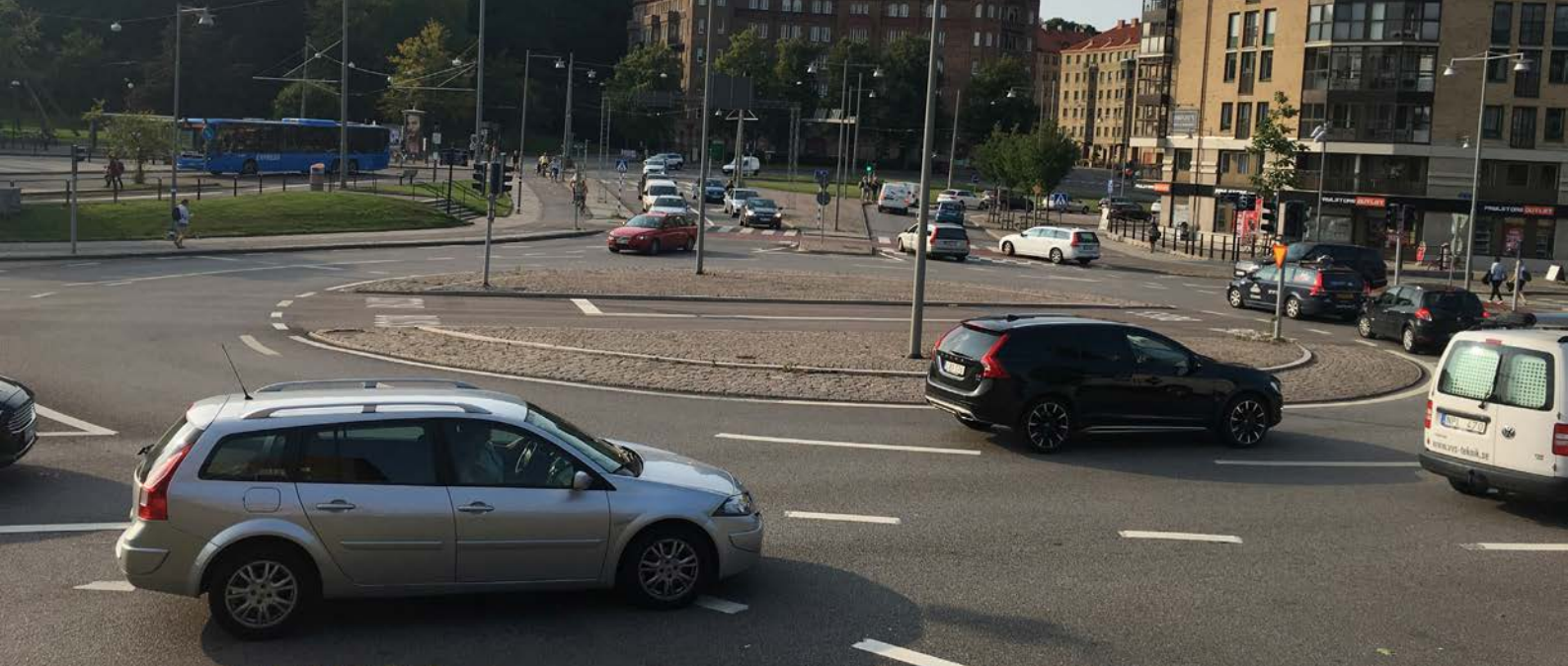
Bild 13: I denna bild syns det bättre hur den genomkörningsbara mittrondellen är utformad. Göteborg. Foto: Maria Nordlöf, WSP.
