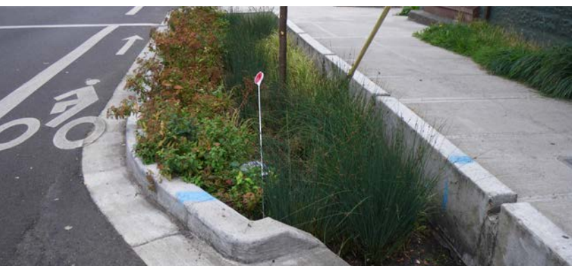
Bild 8: Exempel på dagvattenlösningar som bidrar till ökad stadsmässighet. Till vänster hur en utdragen kantsten kan se ut, till höger hur man kan minska andelen hårdgjord yta. Källa: Sweco
