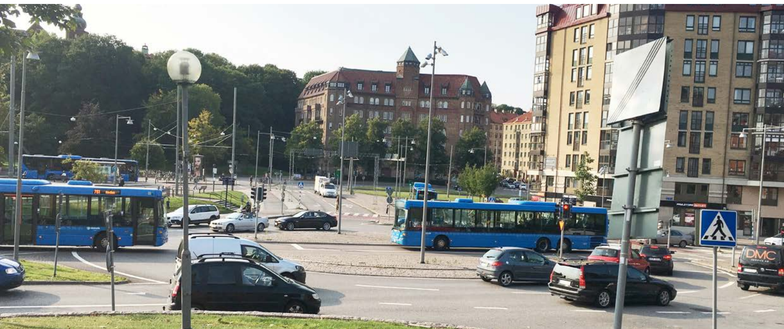
Bild 12: Cirkulationsplatsutformning med prioritet för busstrafik som ska rakt fram. Lägg märke till att trafik i cirkulationen har röd signal, för trafik rakt fram finns separata körfält. Göteborg. Foto: Maria Nordlöf, WSP.
