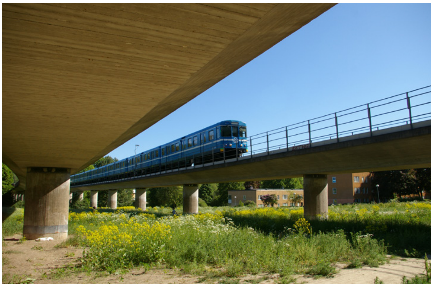
Tunnelbanan som vid Vårbygård är uppbyggd på pelare.
