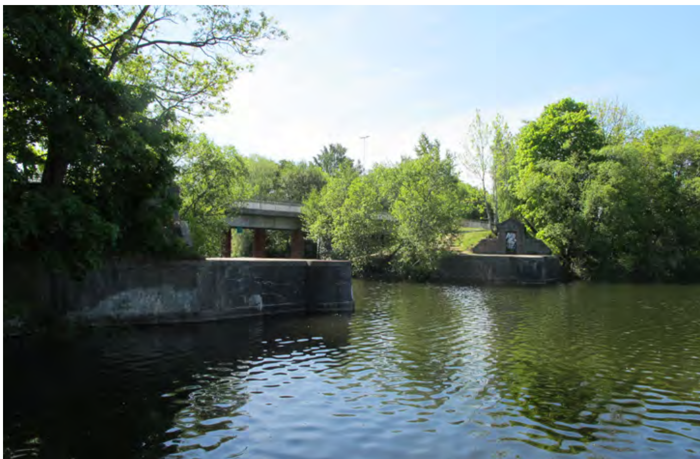
Kontrollstationen för huvudvattenledningen vid sundet mellan Fittjanäset och Botkyrka
