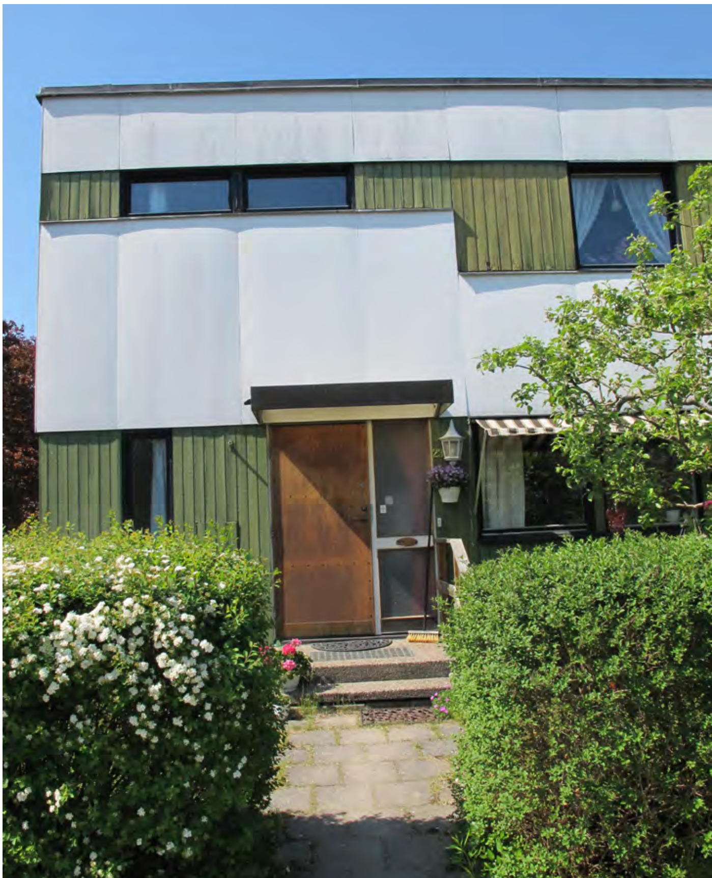
Radhusområdet vid Kalkvägen, här syns tydligt de karaktäristiska fasaderna med skivmaterial och stående panel. Kvarteren bryts av genom avvikande färgsättning.
