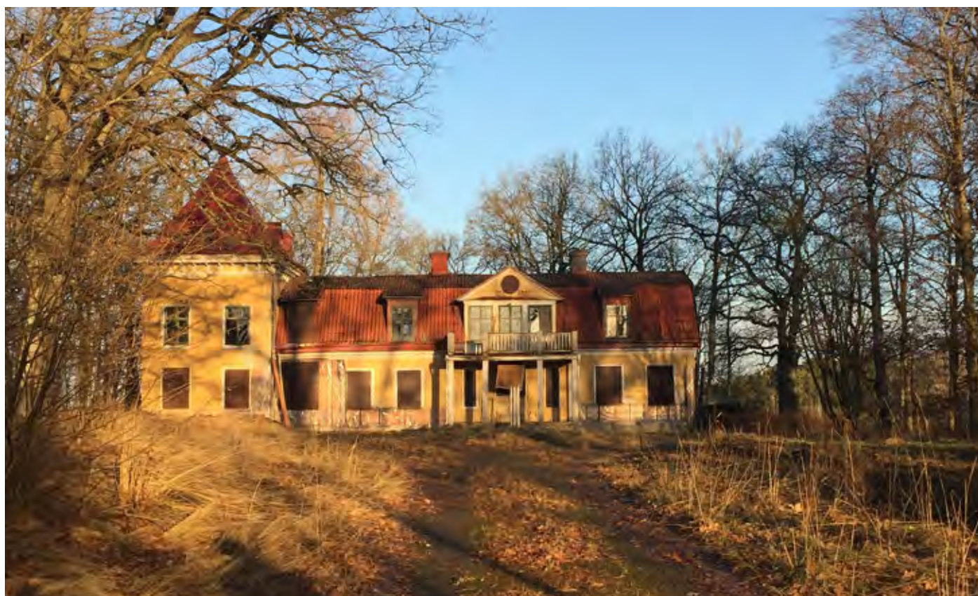
Den karaktäristiska mangårdsbyggnaden till Björksättra.
