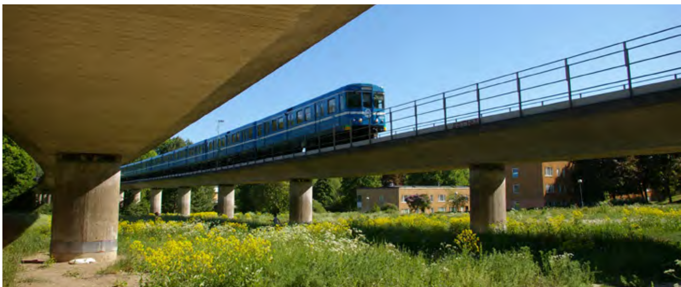
Tunnelbanan med station vid Vårby gård. Spåren går på bro över den öppna parkmarken mellan bostadsområdena.
