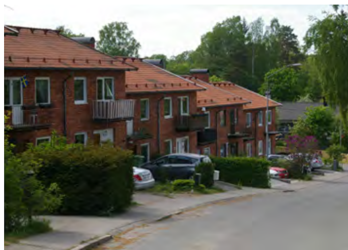
Kv Assessorn vid Tranvägen
