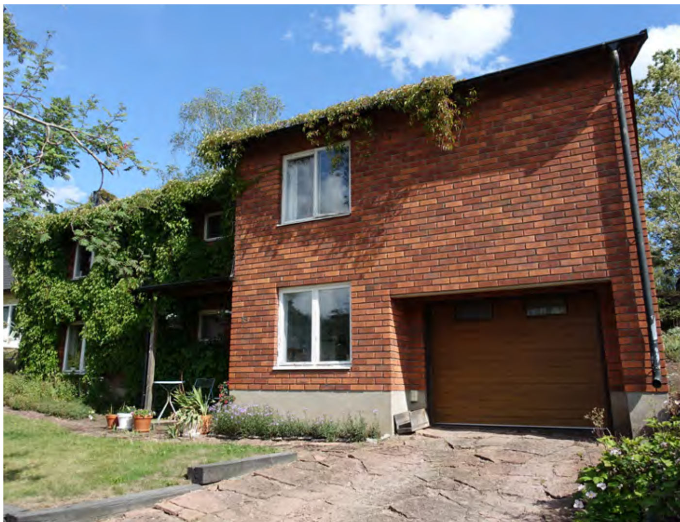
Villa längs med Backslingan i rött tegel.
