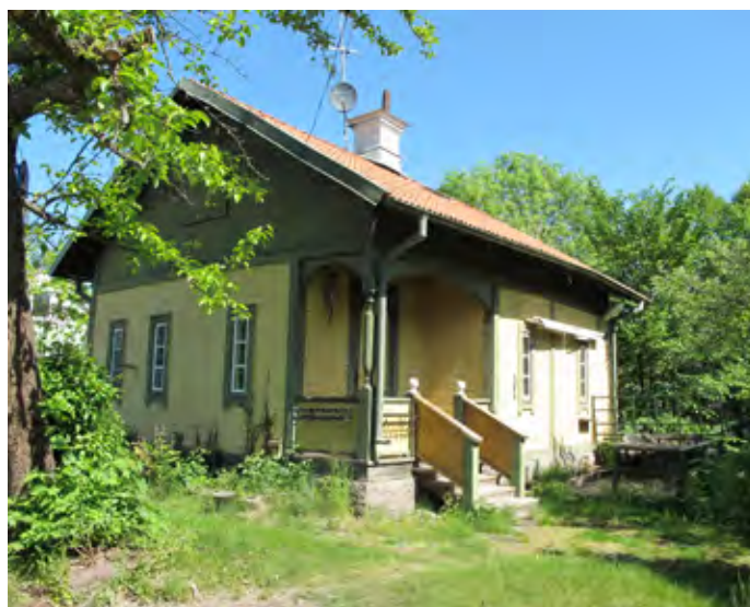
Vattenvaktarstugan vid Fittjanäset
