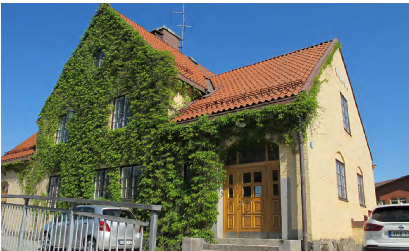
Stuvsta stationsbyggnad från 1919
