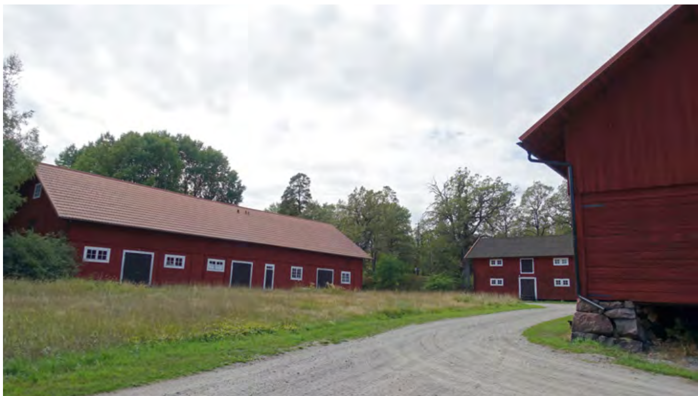
Kvarvarande äldre ekonomibyggnader byggda kring en gårdsplan
