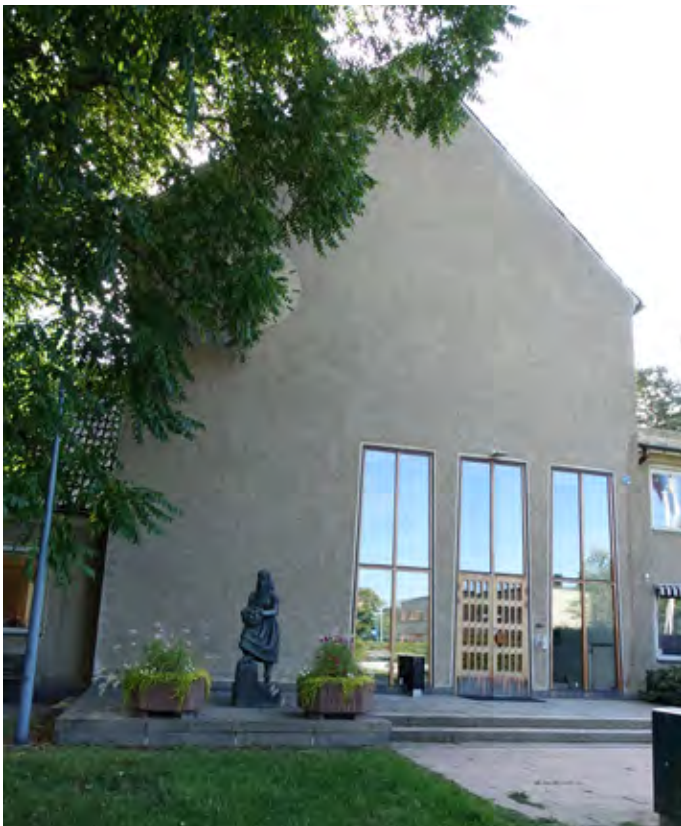
Entrén till kommunalhuset från 1948
