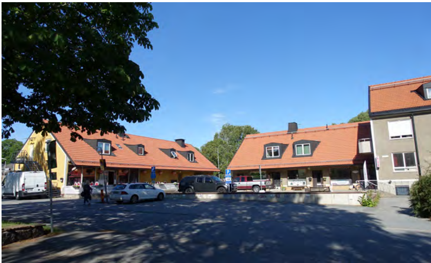
Huddinges första flerbostadshus längs med Kommunalvägen, uppförda 1949
