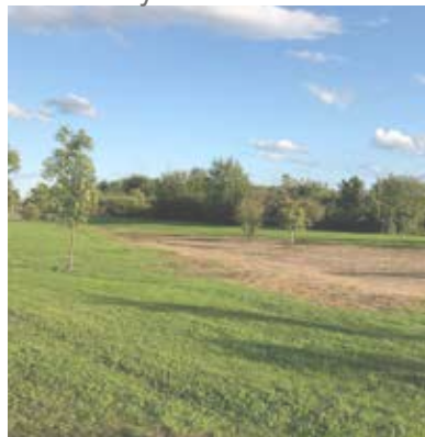
"Skålad" gräsmatta i södra Stockholm, utformad för att samla vatten efter kraftiga skyfall.
