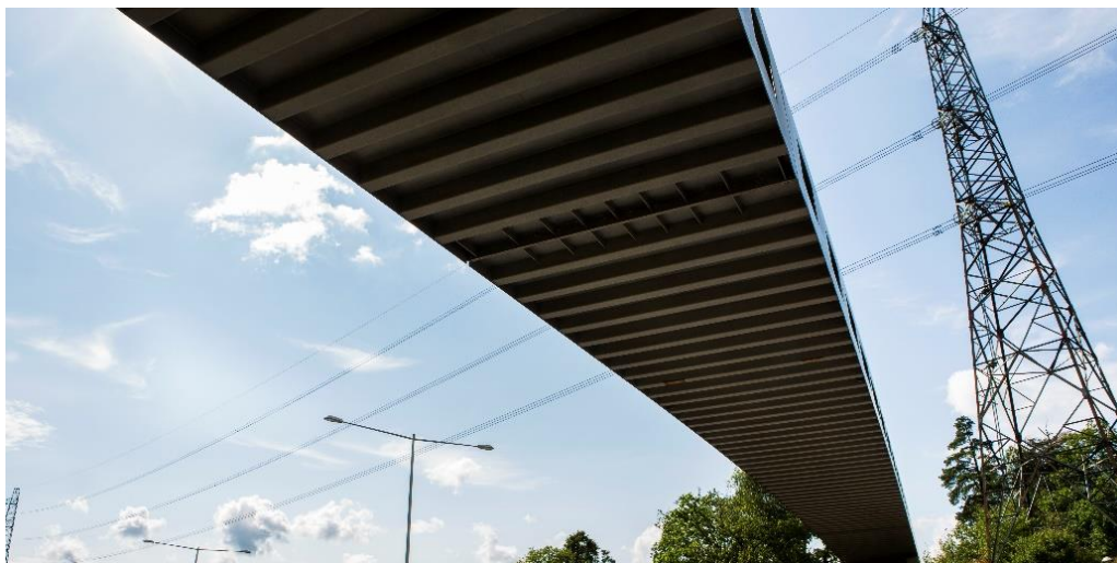
Figur 7. Exempel på luftburen kraftledning. Källa: Huddinge kommun.
