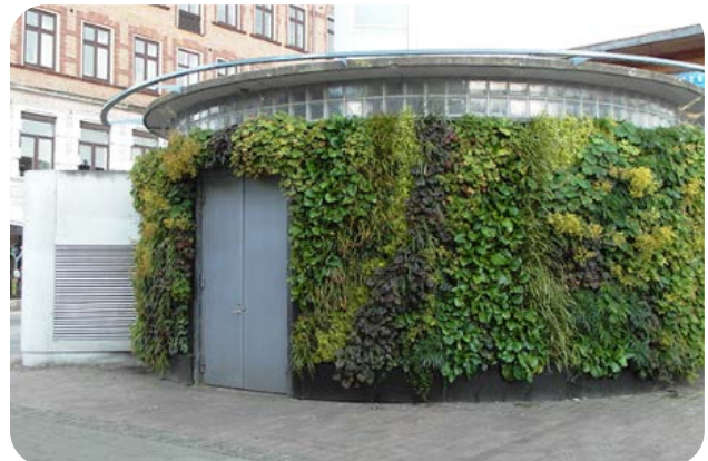
Exempel på fasadgrönska vid Karlbergs station. (Bild: wikipedia)
