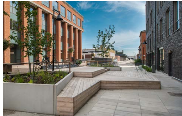
Platsbildning utanför kontor, Malmö. Foto: PE Teknik och arkitektur
